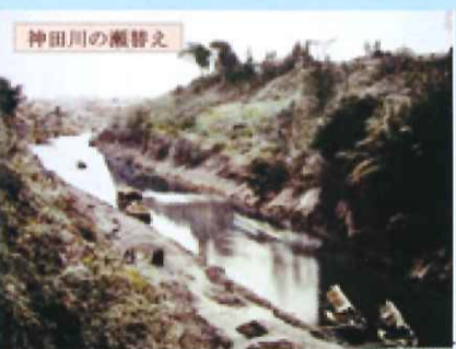
神田川の掘削 海抜十七メートルの神田山を掘削 放水路から舟運路へ
