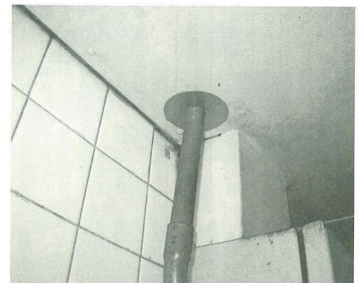
▲写真2 座金による封鎖例 (工事後)
