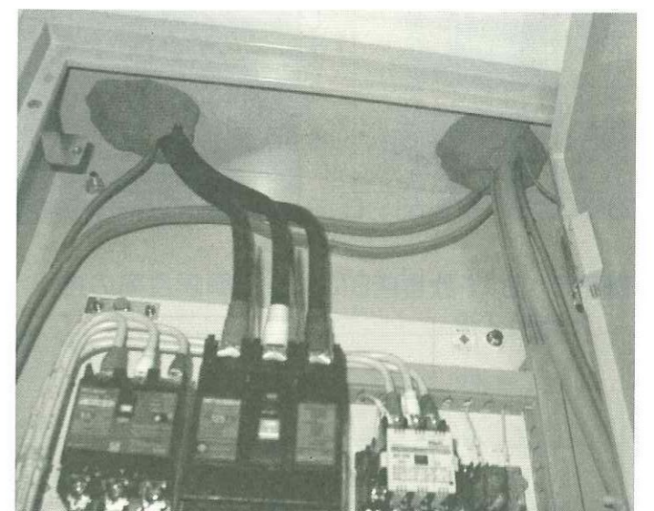
▲写真4 防鼠パテによる封鎖例 (工事後)
