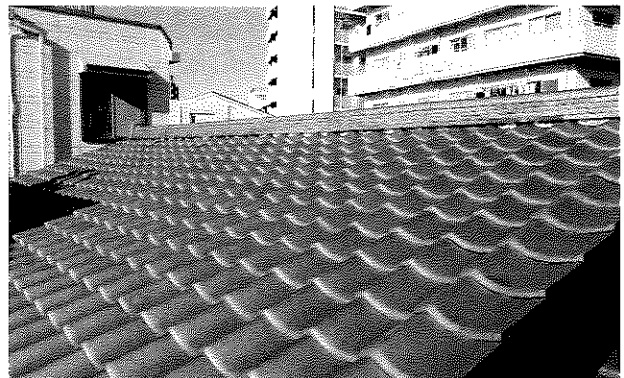
図4 屋根の上部の調査
