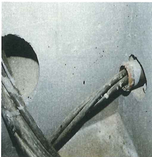
写真8 ビルへのケーブル引き込み部分
