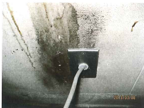
写真 24 コード周囲をステンレスプレート設置
