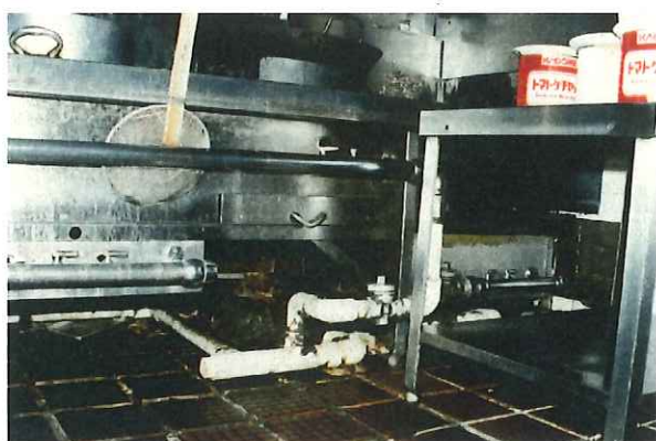
写真 28 厨房機器の下部
