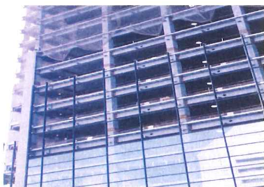
写真 10 カーテンウォールの内部の隙間
