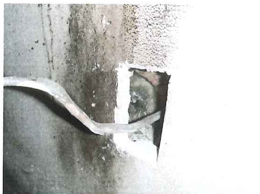
写真 23 冷蔵庫裏の電気コード周囲の隙間
