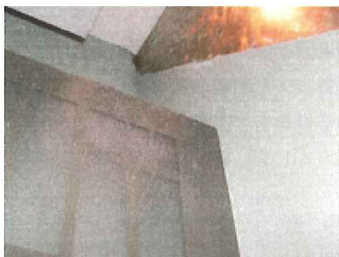
写真 19 間接照明の周りの隙間
