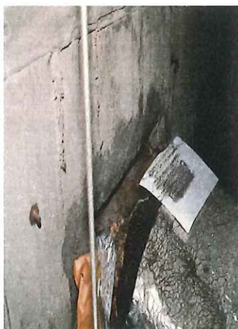
写真 16 ダクト周囲の隙間
