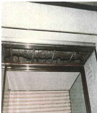
写真 9 ビルとビルの渡り廊下天井の隙間
