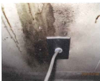
▲写真6 コード周囲にステンレスプレートを設置
