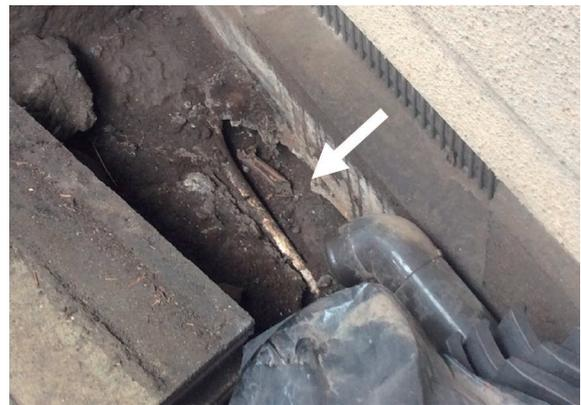
図4 ネズミの屋内侵入口となった外周基礎周りの配管周囲の隙間
