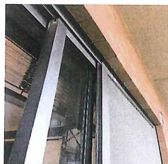
図7 リビングルームの窓 (窓を半開きにしておくと窓 と網戸の間に隙間ができる)
