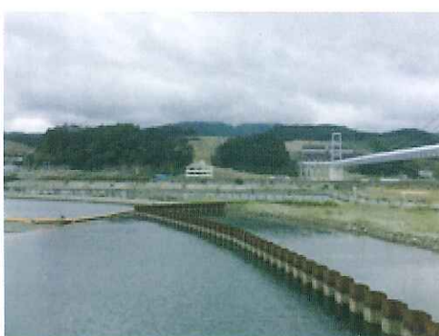
山は削り取られ、大型ベルトコンベアでかさ上げ工事中。復興はまだだ(2015年8月)
